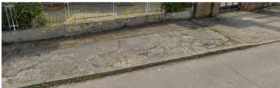
Esempio di pavimentazione dissestata – Via G. Galilei
